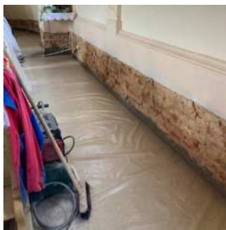
Sanace zdiva kaple v Herticích při realizaci v dubnu 2024
